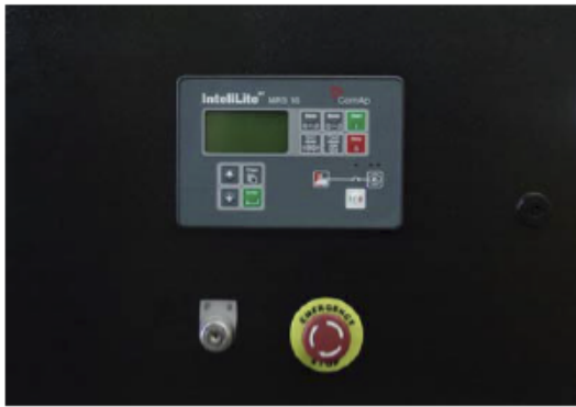
Panel para Encendido Automatico ComAp
